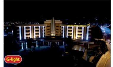
PROJETO EXECUTADO - GLF3
